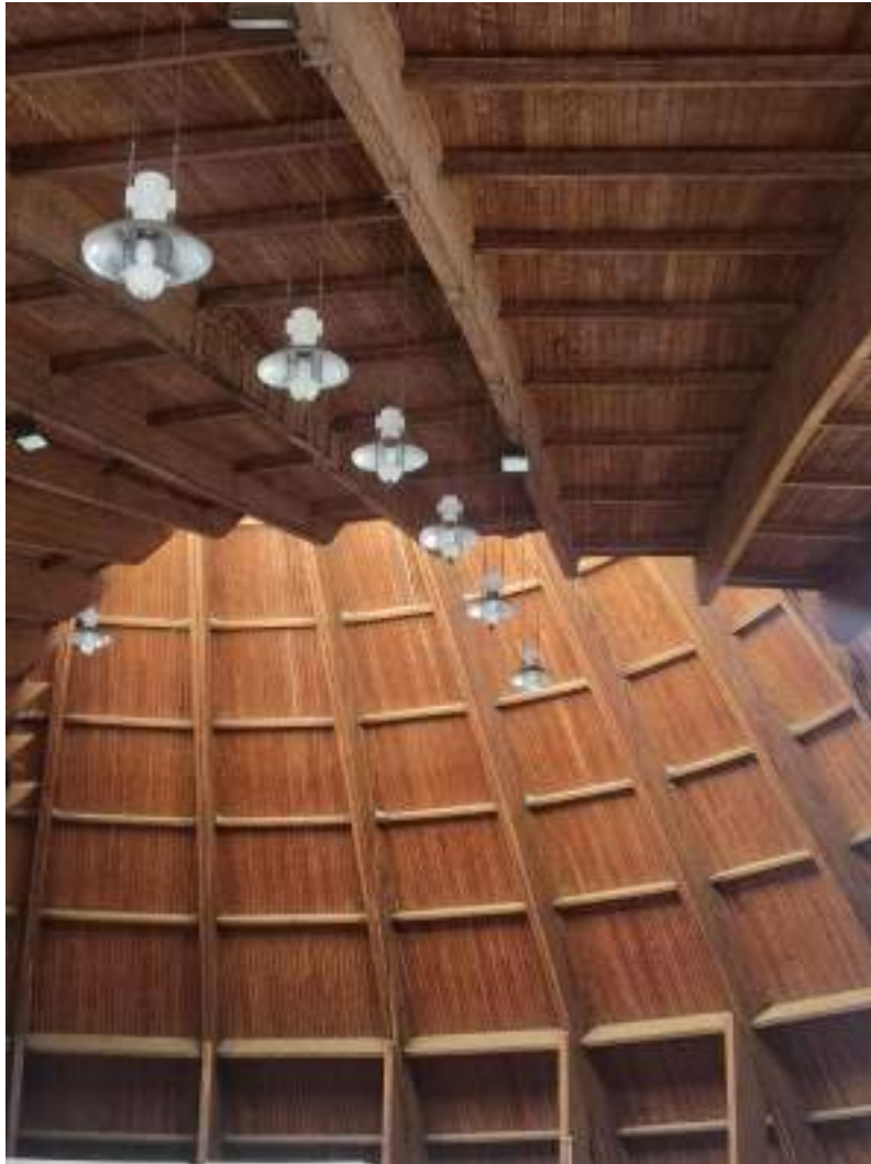
Structure intérieure en lamellé-collé du sanctuaire marial de Mvolye, Yaoundé (Cameroun)
